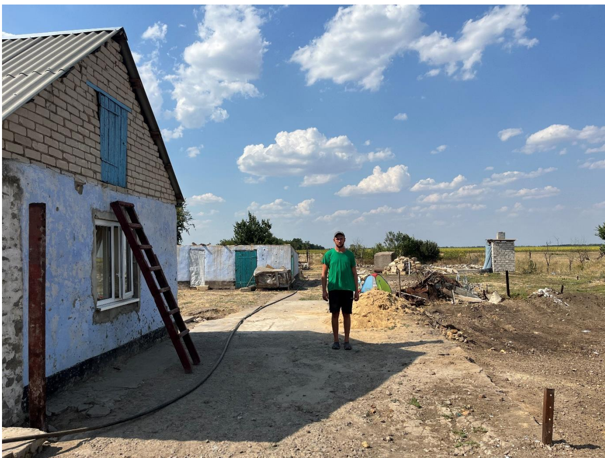
Figuur 4: Andrei bij het bijgebouw die hij ombouwt tot nieuwe woning. Rechts op de foto is de ruimte voor een noodwoning vrijgemaakt. – juli 2024
